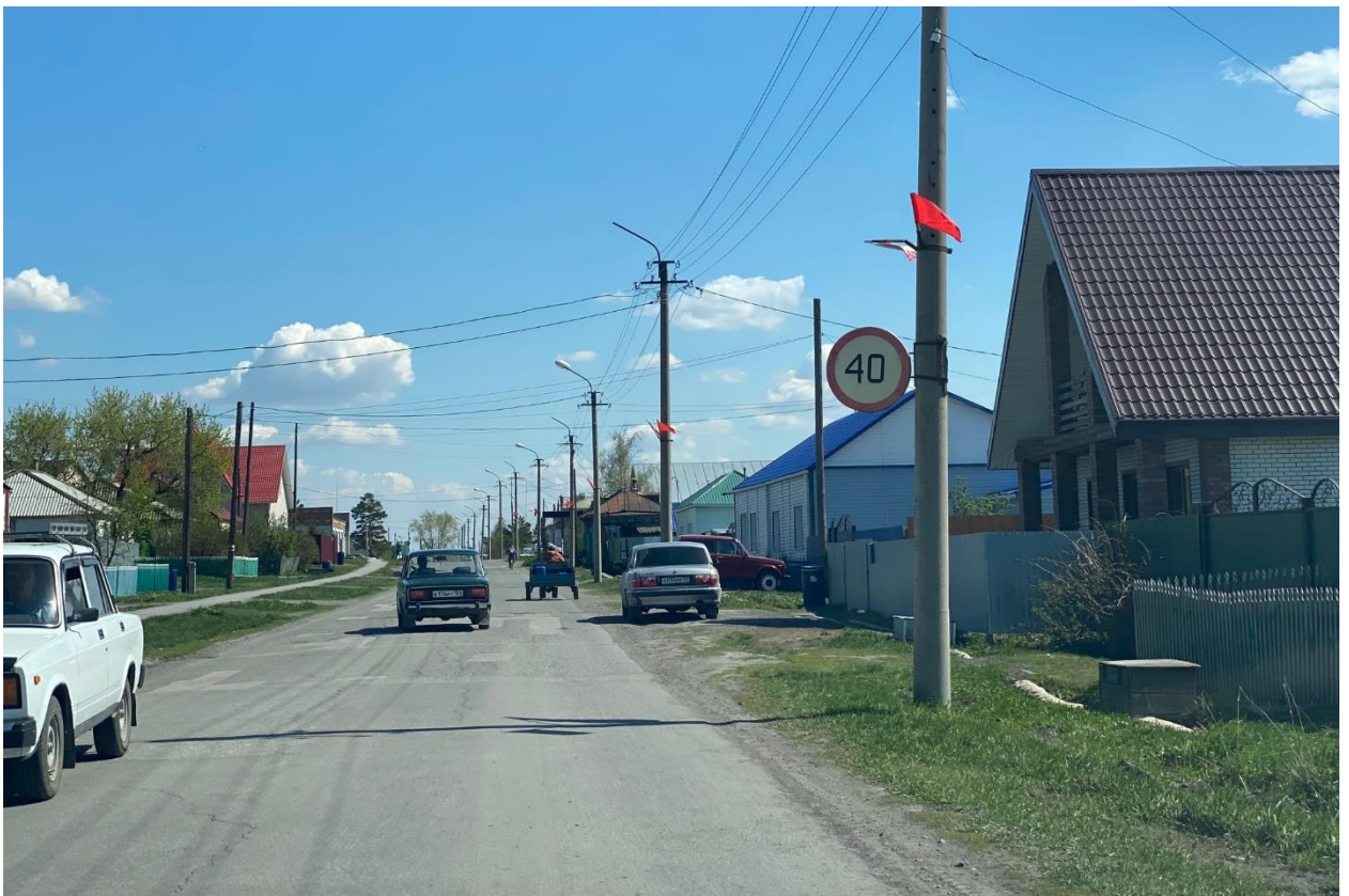
Рис. 3.13.2 – Технические средства организации дорожного движения, установленные не по ГОСТ Р 52289-2019
