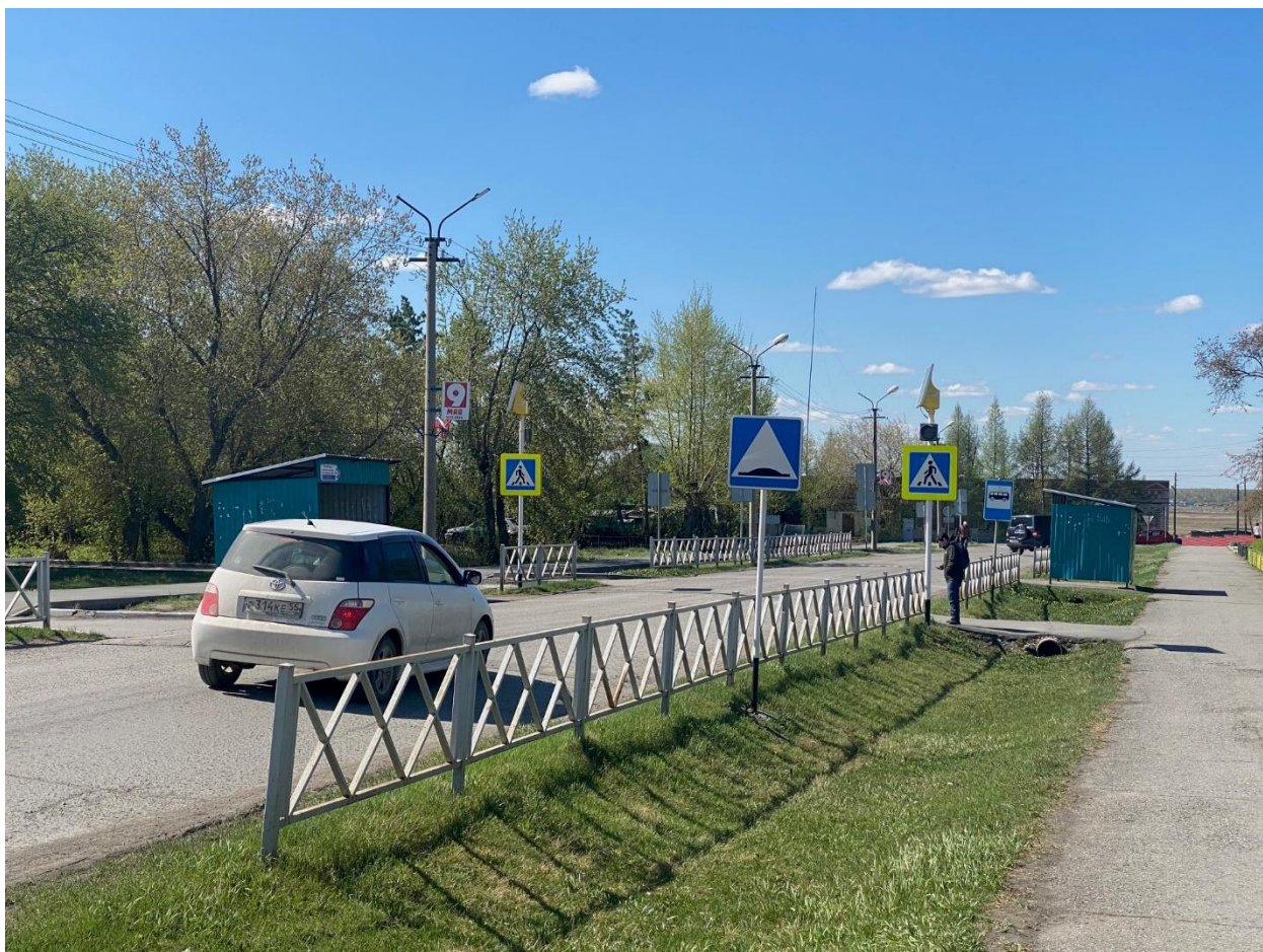
Рис. 3.17.2 –Пешеходный переход, оборудованный ТСОДД
