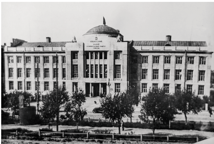
1. Здание – памятник «Дом областных организаций» (Сибревком) (1 января)
